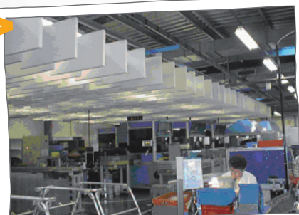
Montage du réseau au dessus et à proximité de machines bruyantes
