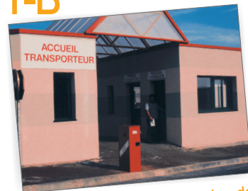
Local d'accueil et d'attente des transporteurs
