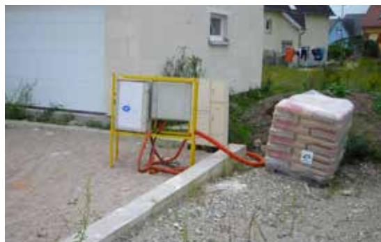
Stockage aux emplacements dédiés
