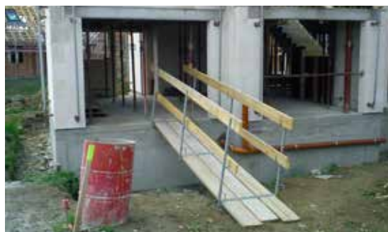
Passerelle stable et protégée
