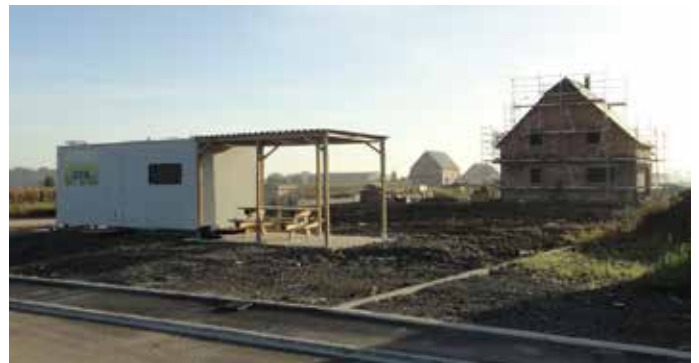
Exemple de base vie de lotissement
