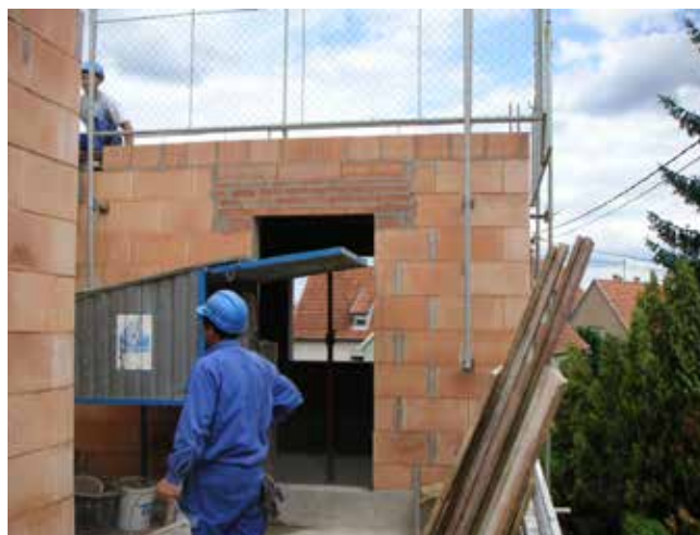
Protections fixées dans la maçonnerie
